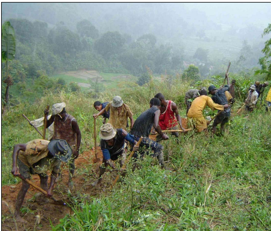
Sous une pluie battante, les villageois de Vavatenina (Madagascar) creusent 2,3 Km de tranchée. L'adduction alimentera 2 villages regroupant 520 personnes.
