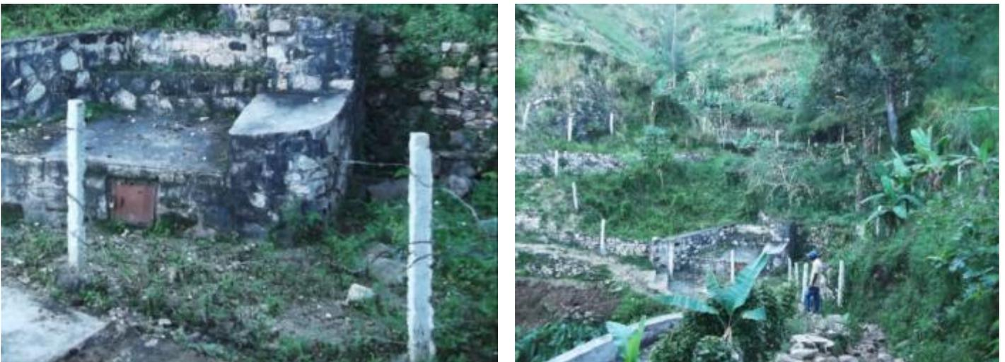
**Photo 7 : RAFASAP Blondo.** Captage réhabilité par Helvetas en 2011, périmètre clôturé avec fil de barbelée et poteaux béton
