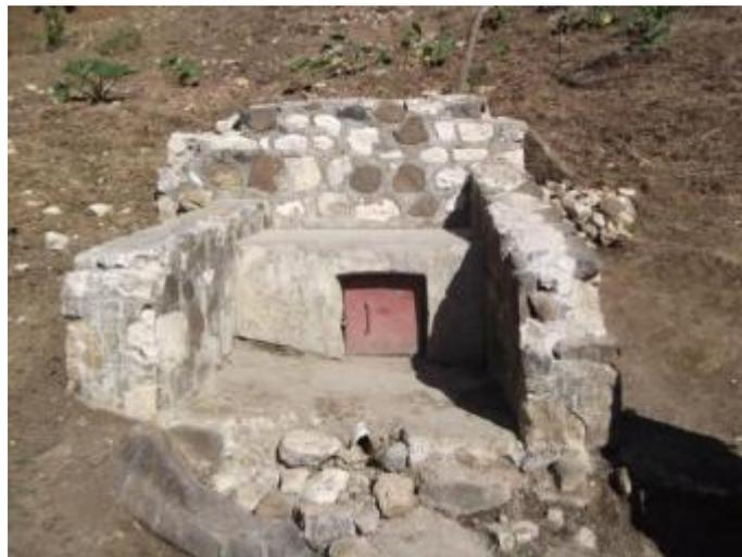
RAFASAP : Verisen. Système construit en 2004 et fortement dégradé. La cause probable est la mauvaise qualité de sable, un bès peu formé et des mélanges de mortier trop pauvres pour la maçonnerie.
