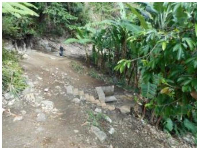
Il semble préférable de construire des structures de tailles restreintes mais qui comportent tous les aménagements nécessaires. Par exemple le captage de Kofi, possède en plus d'une BC protégée, une BF avec un accès simple mais fonctionnel et une évacuation satisfaisante.
