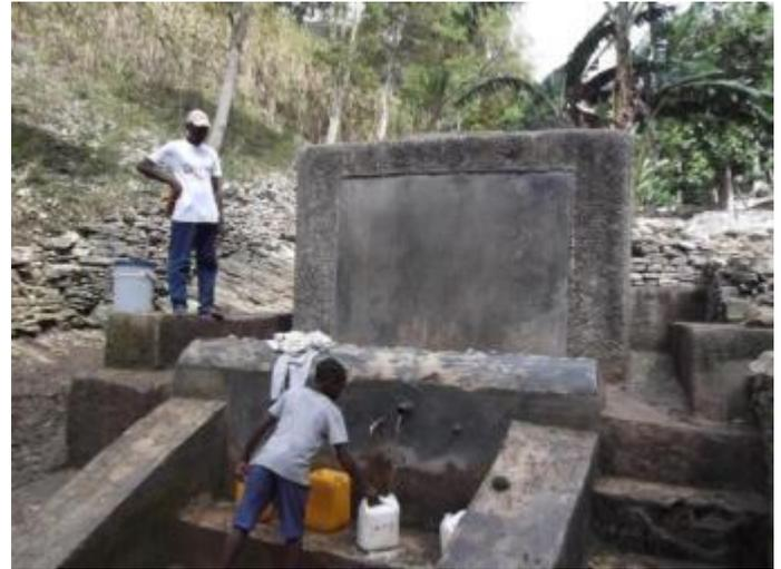
REZOBONDLO : Delat. Robinet HS et condamné, réservoir plein, service au trop-plein
