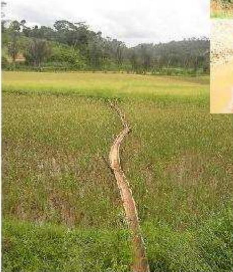
**Ouvrage en bambou pour traverser une rizière en contre-bas (ci-dessus)**
