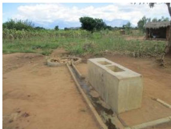
*Ancien point d'eau réalisé par inter Aide : drainage et point de lessive*
