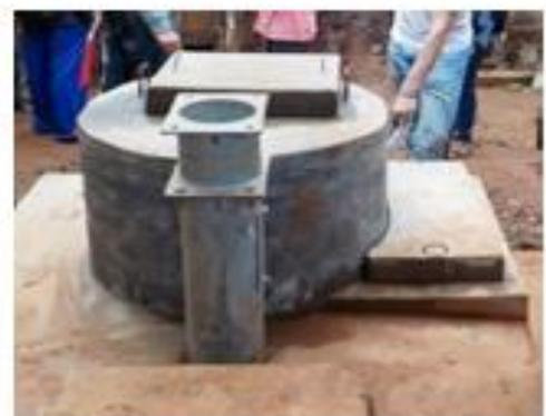
Vue arrière (ci-dessus) et avant (ci-dessous) du dispositif avant installation de la pompe
