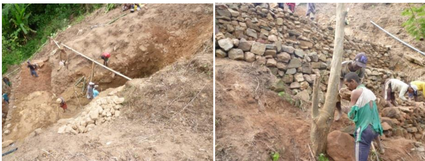
Figure 6: Travaux de captage d'Ambodimanga Ravahiny en Avril 2014
