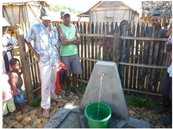
Figure 6 : Borne fontaine du réseau d'Antsiradava lors de la réception provisoire des ouvrages.
