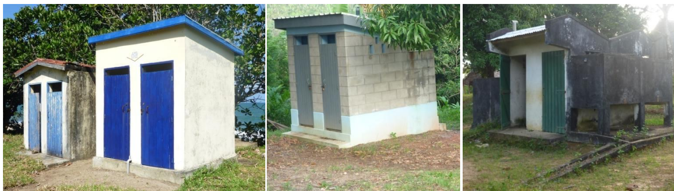
Figure 21: A gauche : Latrines au CSB I de Manankatafana – A droite : 2 latrines à l'EPP de Sahaka.
