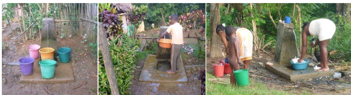
Figure 18: Les 3 bornes-fontaines partiellement fonctionnelles (robinets cassés).
