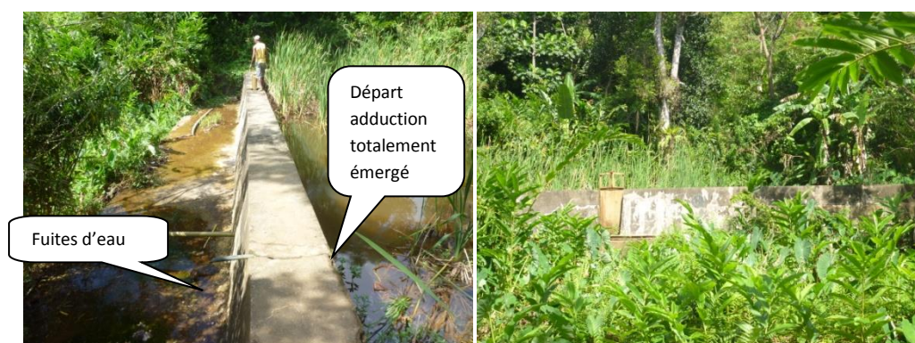
Figure 11: L'ouvrage de captage Andavaniobe (barrage équipé de vanne métallique)
